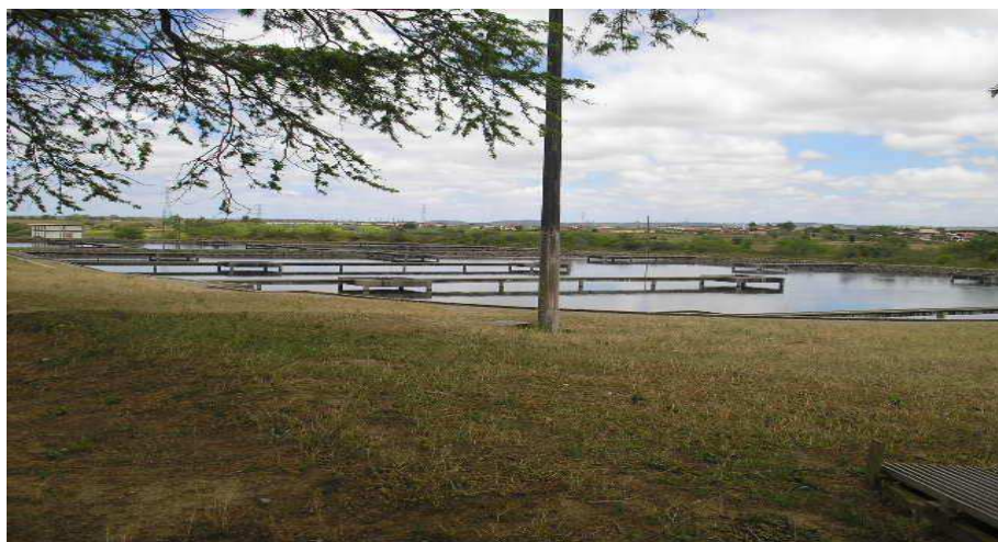
Figura 4 – Estação de Tratamento de Efluente (ETE-Campina Grande-PB).
