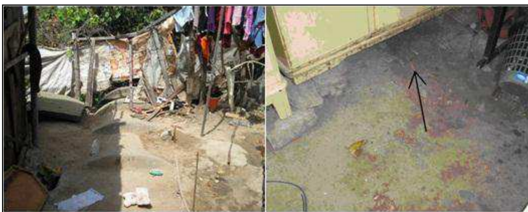
Figura 12 – Fotos das residências de pesquisados, construídas em cima dos emissários, Bairro da Catingueira- Campina Grande PB.
