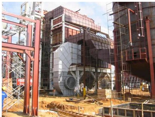
Figura 4 – Usina de Biomassa de Lages – SC. Fonte: Aeroar – Caldearia, 2011.
