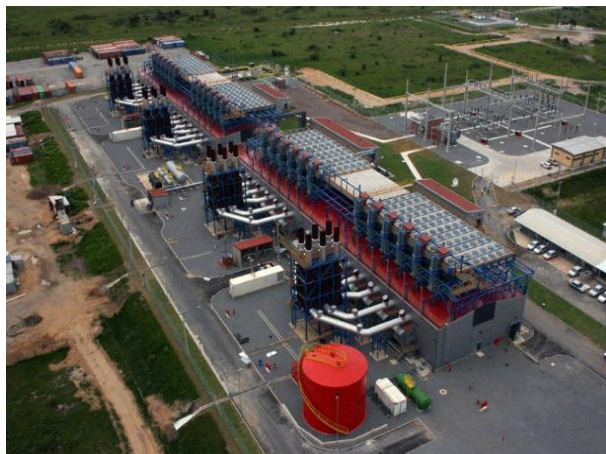
Figura 2 – Usina Termelétrica de Linhares – ES. Fonte: Prefeitura de Linhares – Primeira Termelétrica a Gás Natural do País, 2011.
