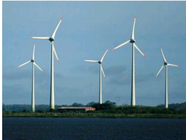
Figura 5 – Parque Eólico de Osório – RS. Fonte: Ventos do Sul Energia – Galeria de Fotos, 2011.
