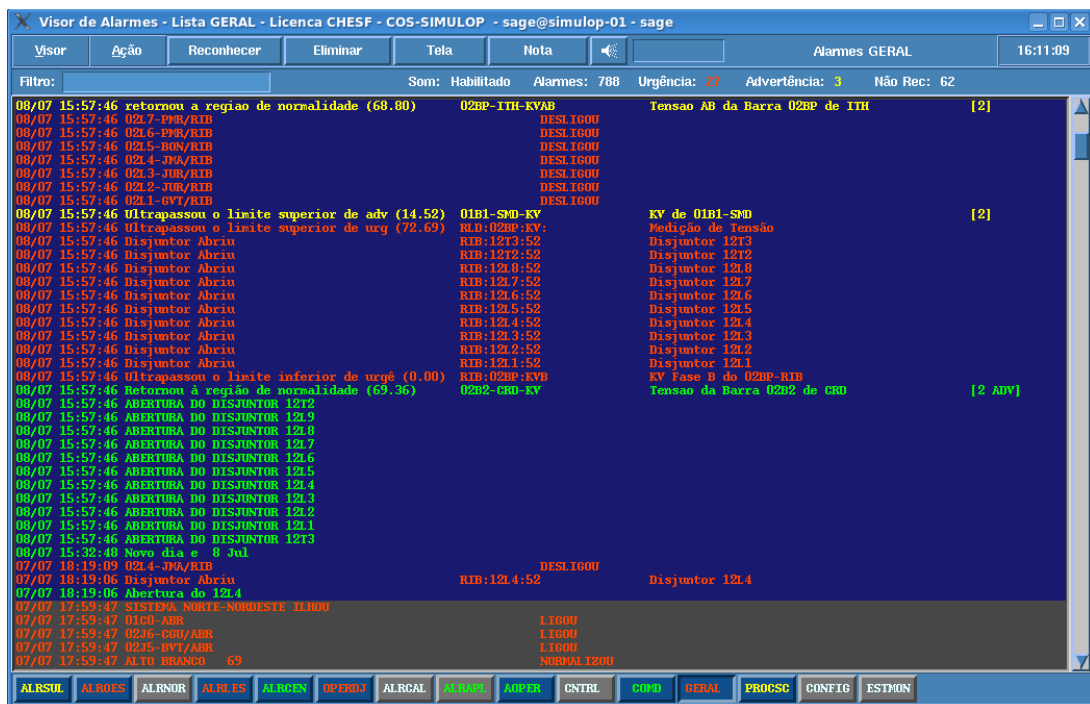
Figura 5.23: Visor de Alarmes geral indica a mudança de estado dos equipamentos na RIB
