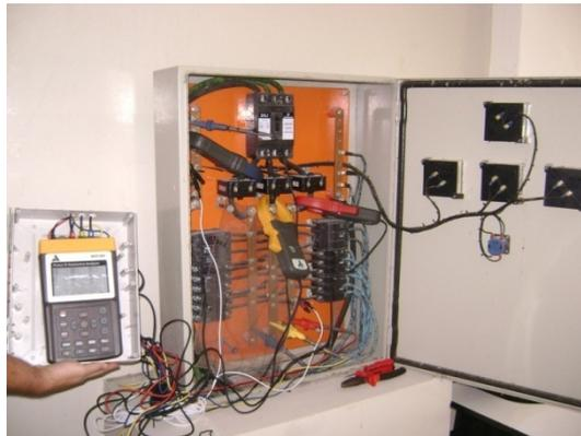
Figura 5.3: Analisador de Energia instalado em um PAC.
