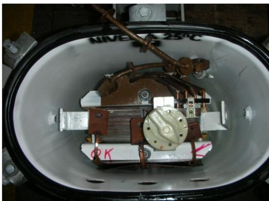
**Figura – Fotografia da parte ativa dentro do tanque.**
