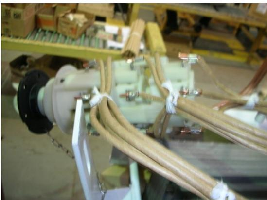
**Figura – Fotografia do TAP de um transformador.**
