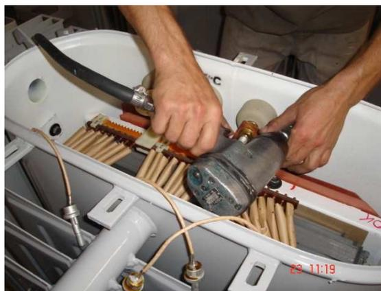
**Figura – Fotografia mostrando os terminais BT sendo parafusados.**
