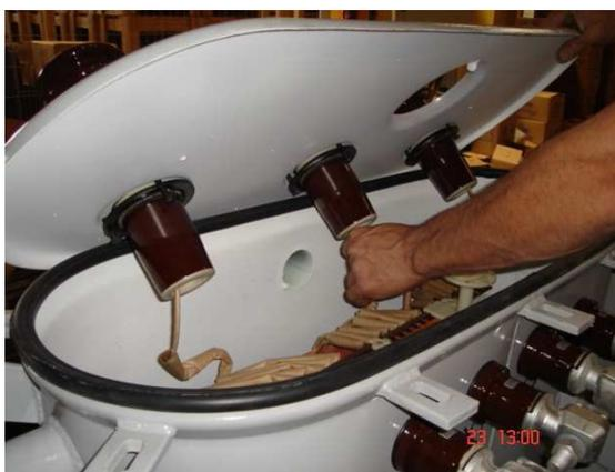
**Figura – Fotografia mostrando os terminais AT sendo encaixados.**
