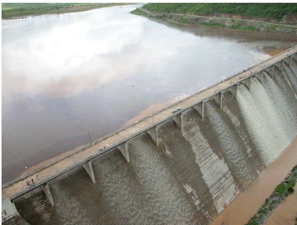
Figura 5.3 – Reservatório Argemiro de Figueiredo (Acauã).
