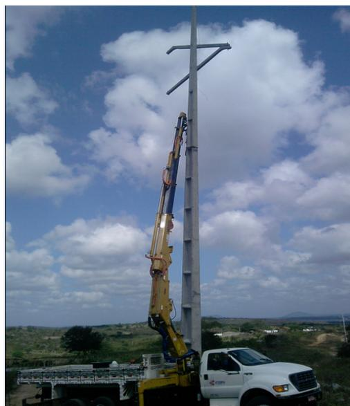
Figura 4: Implantação de uma estrutura do tipo C-AR1.
