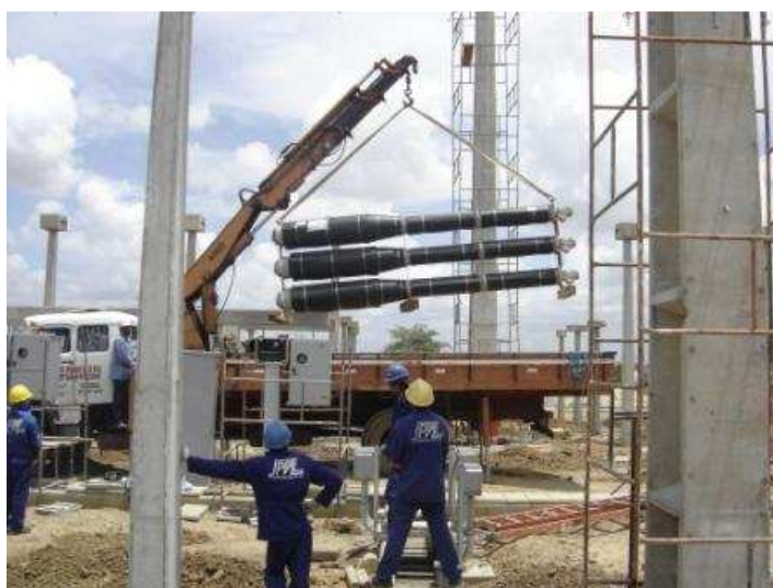
Figura 24 – Fotografia da estrutura suporte para transporte dos pólos do disjuntor.
