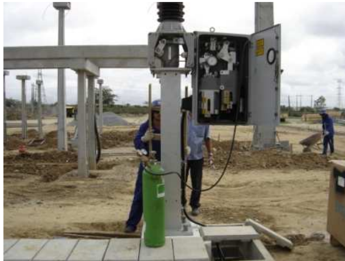
Figura 27 - Fotografia do processo de inserção de gás SF 6 no disjuntor.
