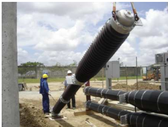
Figura 25 – Fotografia do içamento e um dos pólos do disjuntor.
