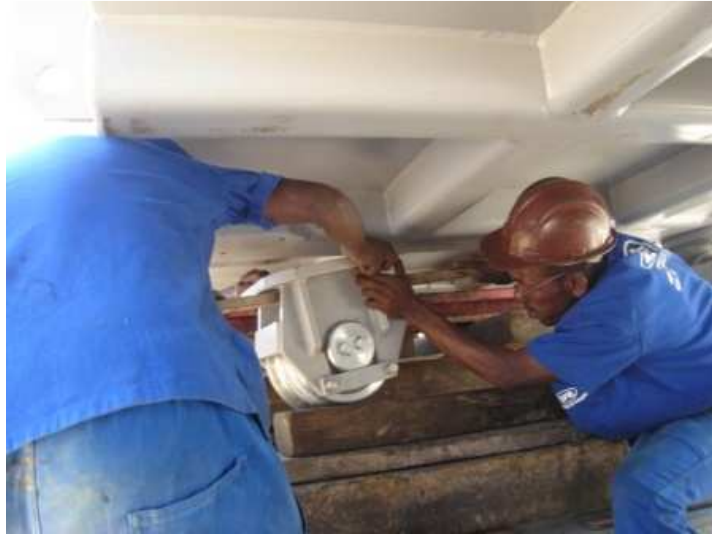
Figura 49 - Fotografia da montagem das roldanas sob a base do transformador.
