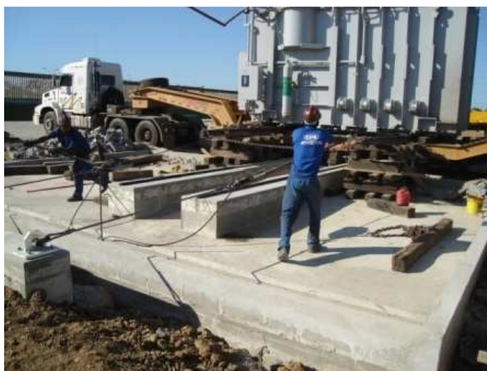
Figura 48 - Fotografia do esquema utilizado para instalação do transformador à base.
