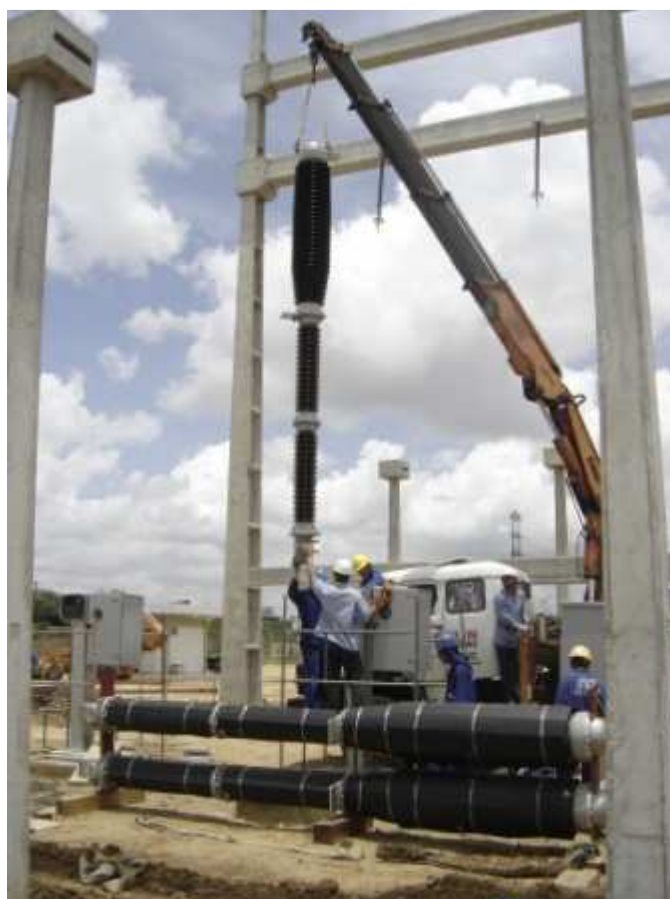
Figura 26 – Fotografia da montagem de um pólo do disjuntor à base.
