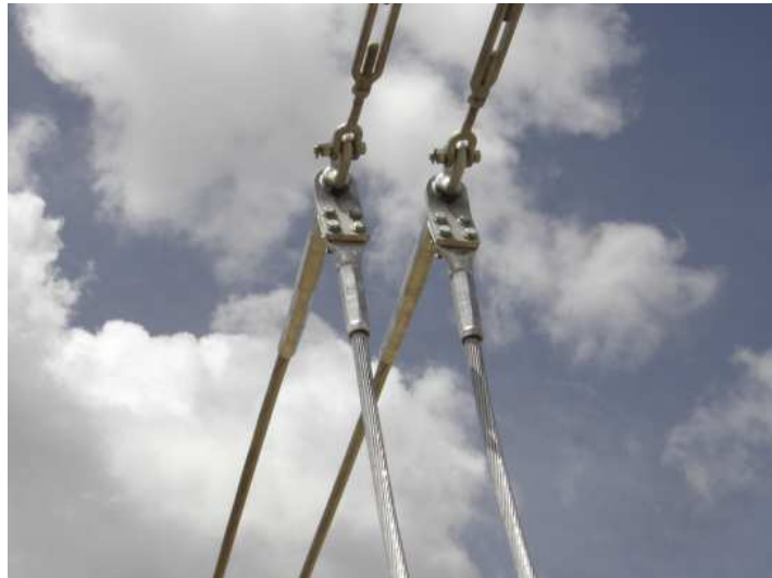
Figura 12 – Fotografia dos grampos de ancoragem a compressão em alumínio - setor 230 kV.
