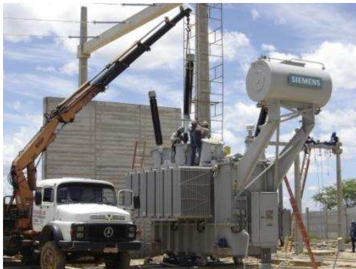
Figura 50 - Fotografia da montagem das buchas do transformador.
