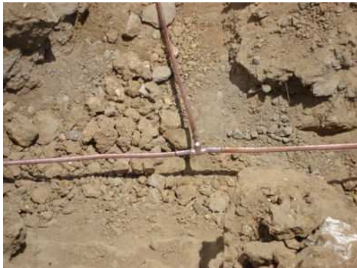
Figura 16 - Fotografia da conexão, por solda exotérmica, dos cabos da malha de terra.
