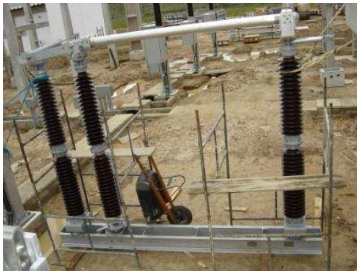
Figura 37 - Fotografia da montagem da seccionadora de abertura vertical.
