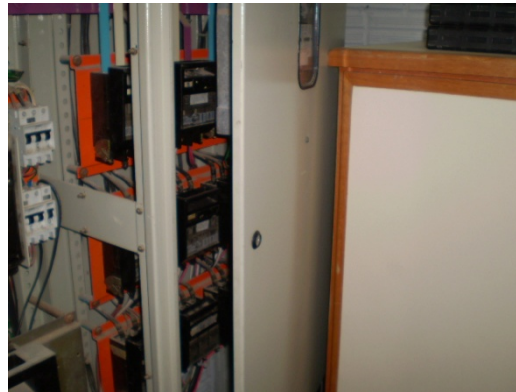
Figura 33-Quadro elétrico obstruído
