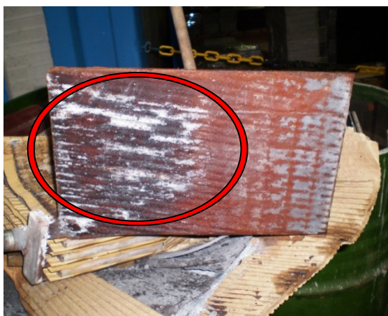
Figura 34-Placa positiva com grande quantidade de sulfato de chumbo
