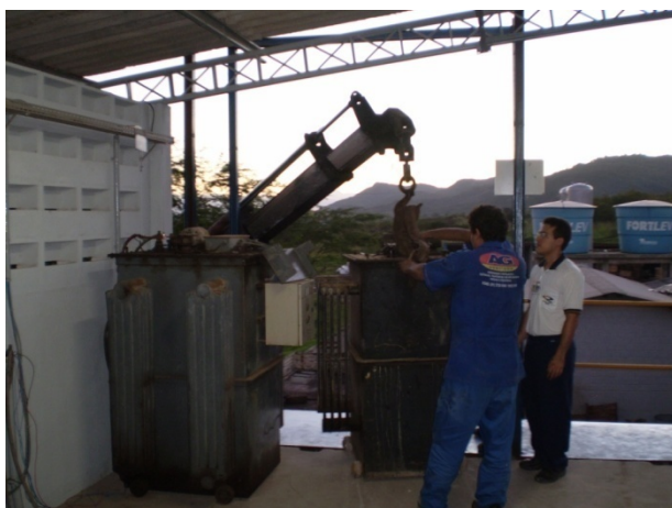
Figura 30-Retirada de retificadores com defeito
