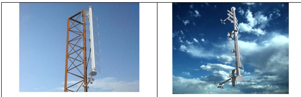
Figura 9: Antena omnidirecional da TV Itararé.
