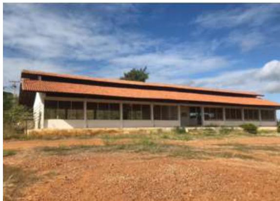
a. Fachada norte
