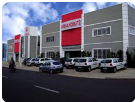
Figura 2 – AREVA KOBLOITZ São José do Rio Preto
