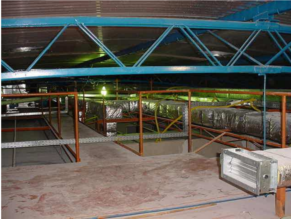
Passarela de manutenção
