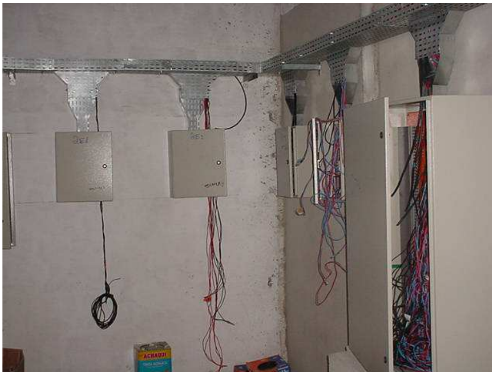
Aplicação de Eletrocalhas e (Obra do Lafare)
