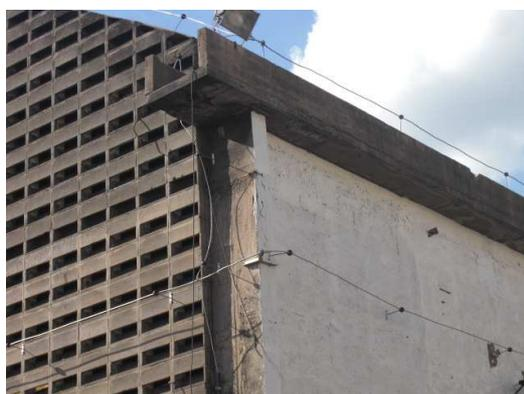
**Figura 48: Anel Lateral e Superior no Antigo Galpão da Expedição**
