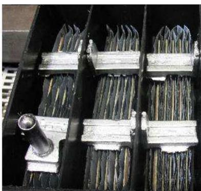
**Figura 9. Conjunto de células ligadas aos straps e aos terminais.**
