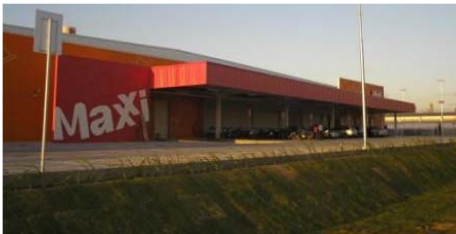
Figura 3.1 – Fachada do MAXXI Atacado, já em fase final de construção.
