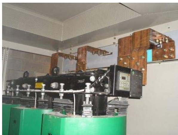
Figura 5.11 – Detalhe da instalação do trafo ao QGBT através do barramento de baixa tensão.
