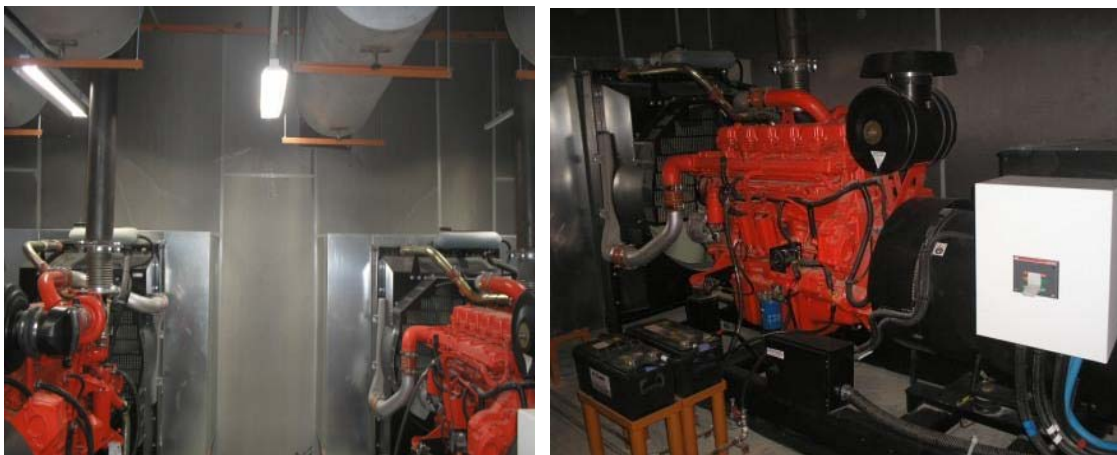
Figura 5.12 – Grupo gerador que atua em paralelismo (esquerda) e detalhe de um dos geradores (direita).
