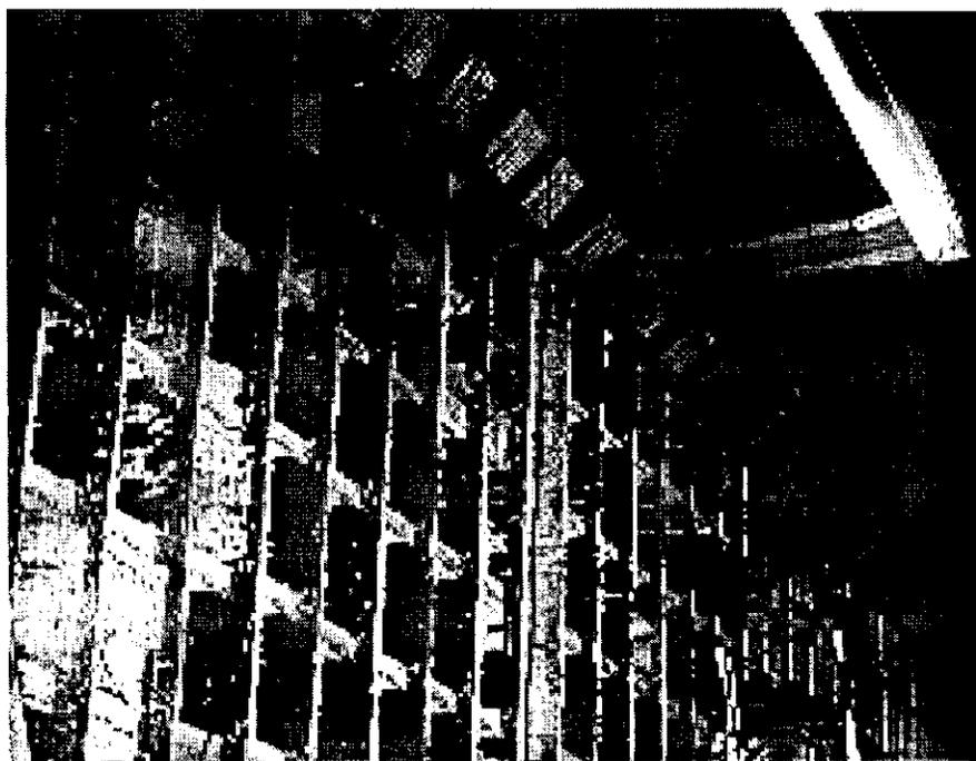
Figura 1: Blocos Verticais no Distribuidor Geral DG.
