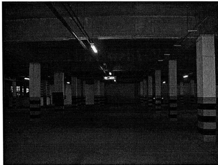
Figura 8 - Caminho a ser seguido pela tubulação galvanizada
