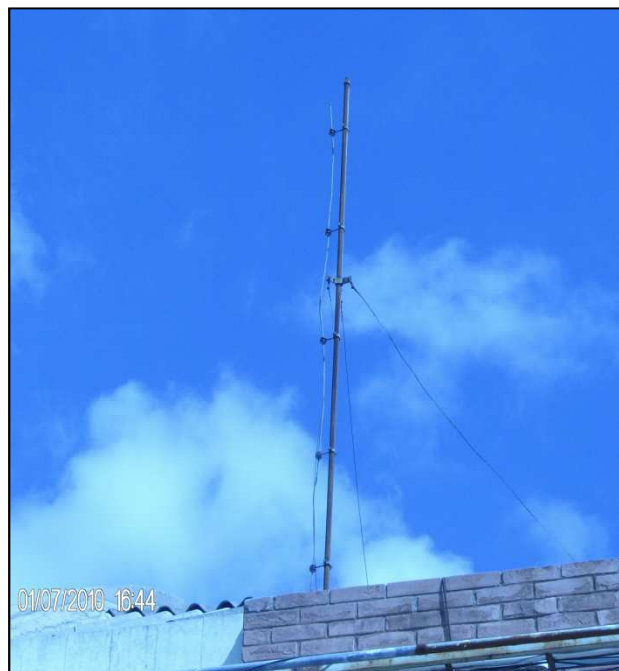
Figura A12 – Componentes de SPDA Antigo – Mastro sem Captor
