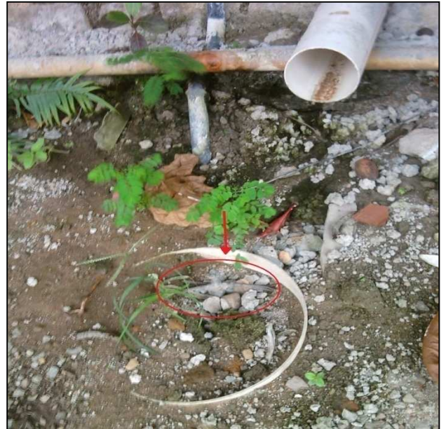
Figura A7 – Caixa de Inspeção tipo solo em PVC sem Tampa
