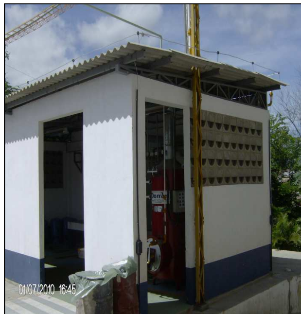
Figura A11 – Tubulações de Gás próximas aos Cabos de Descidas
