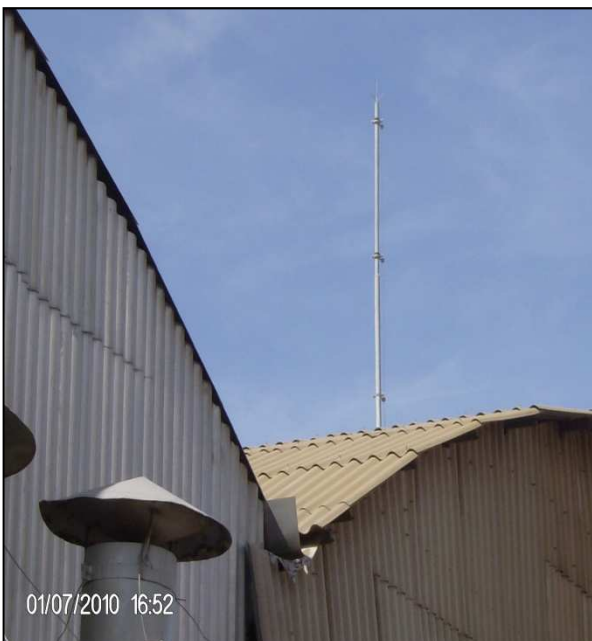
Figura A2 – Haste Franklin no Galpão de Acabamento
