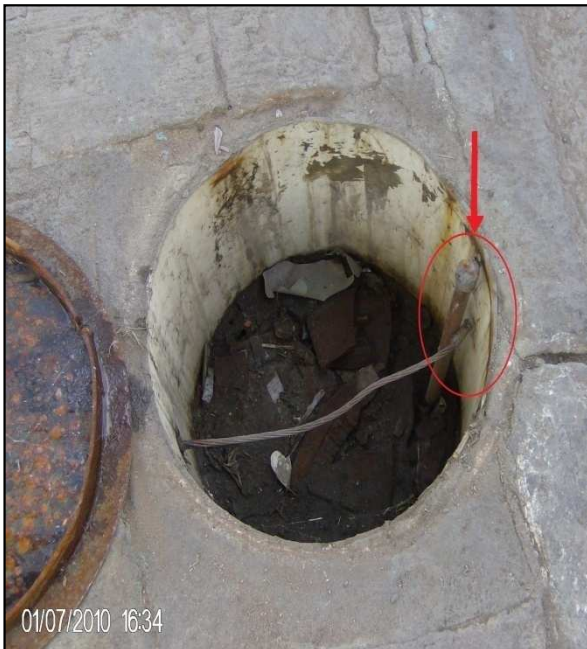
Figura A6 – Cabo de descida não Conectado com a haste de Aterramento
