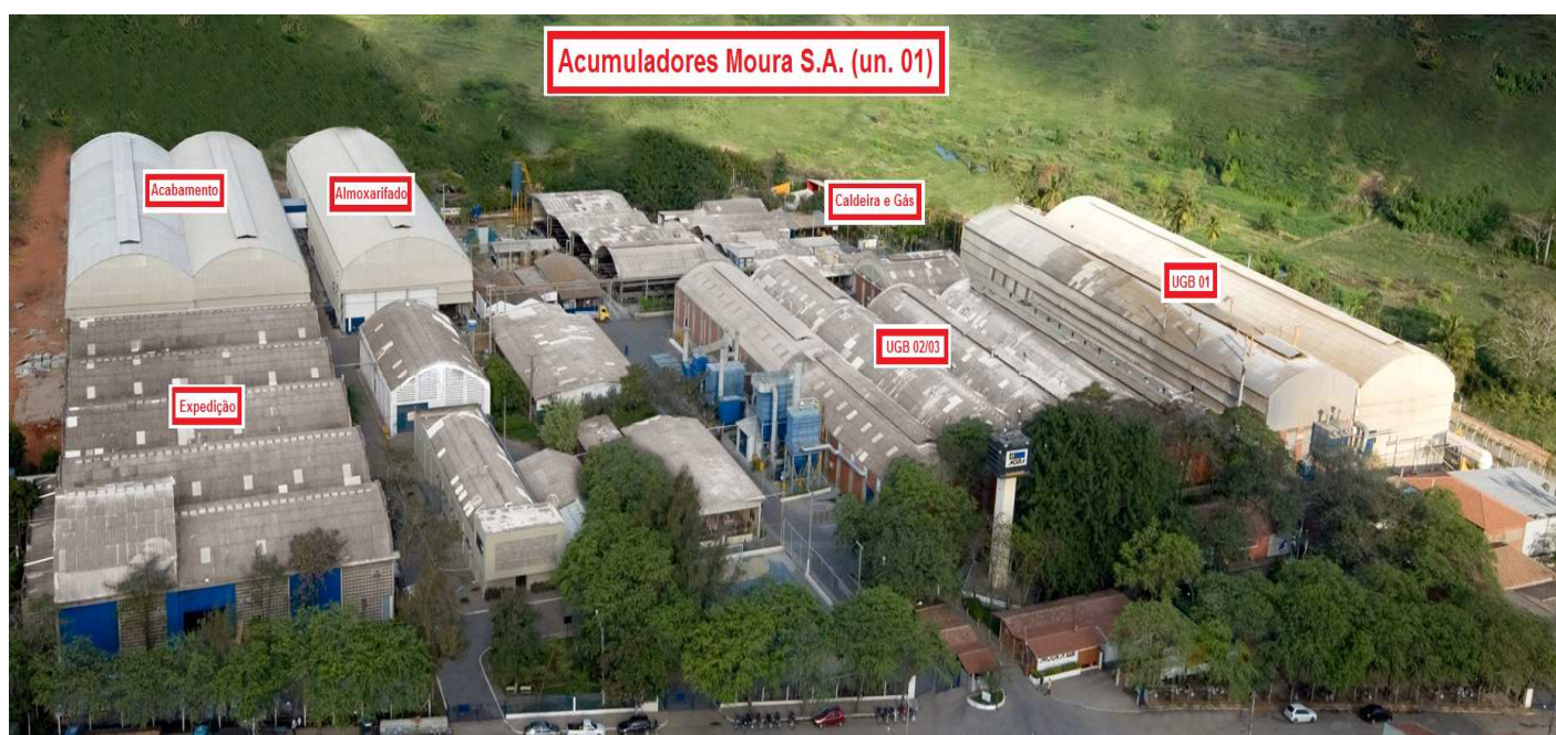
Figura 5.1.1 – Acumuladores Moura S.A., Unidade 01.
