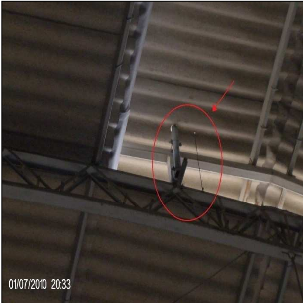
Figura A5 – Conexão do Cabo de Descida da Haste Franklin com a Ferragem da Armação do Galpão
