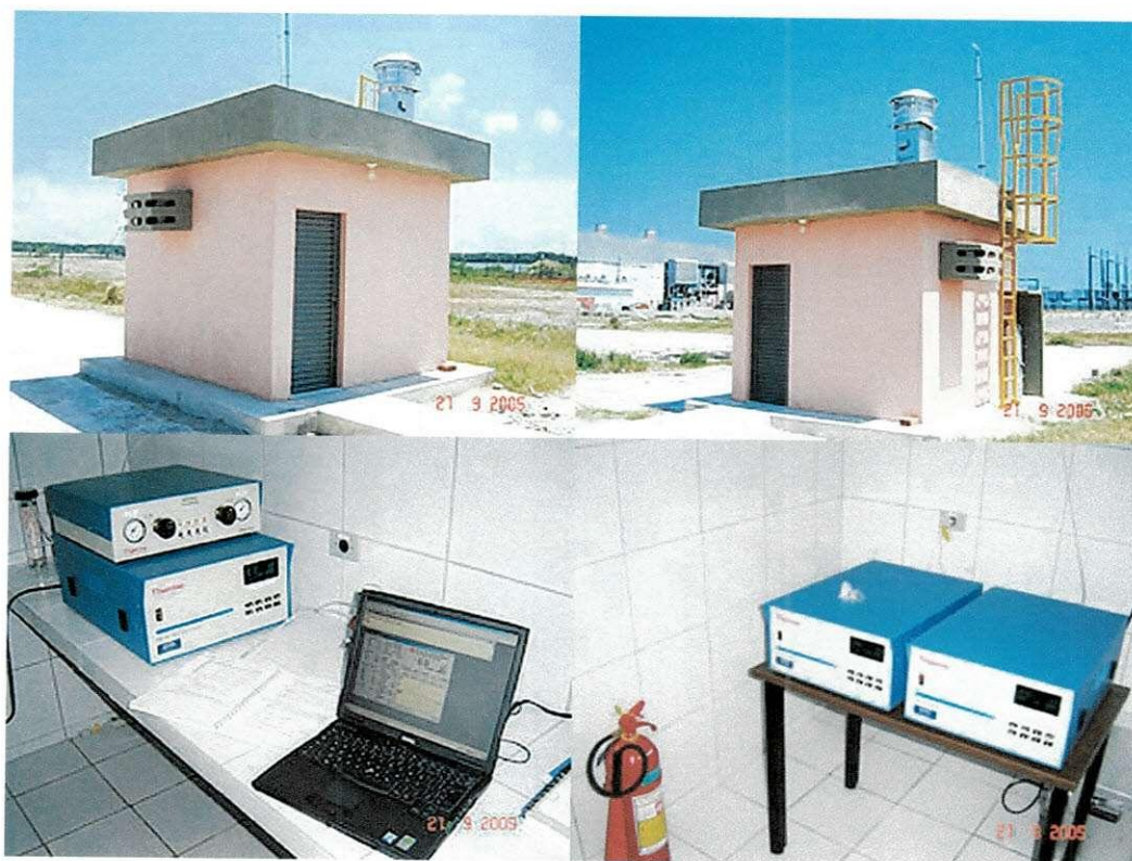
Figura 23 - Fotos da estação em estado final
