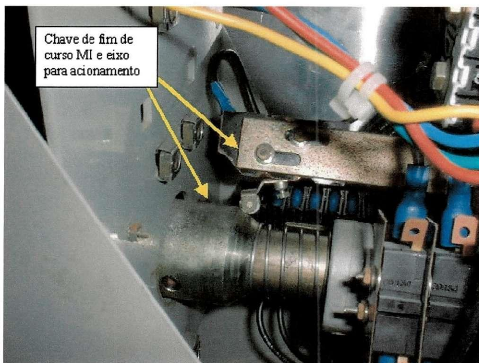
Figura 29 Chave de fim de curso do acionamento da seccionadora 89SS
