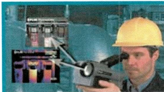
Figura nº3: Verificação termográfica c/ termovisor.
