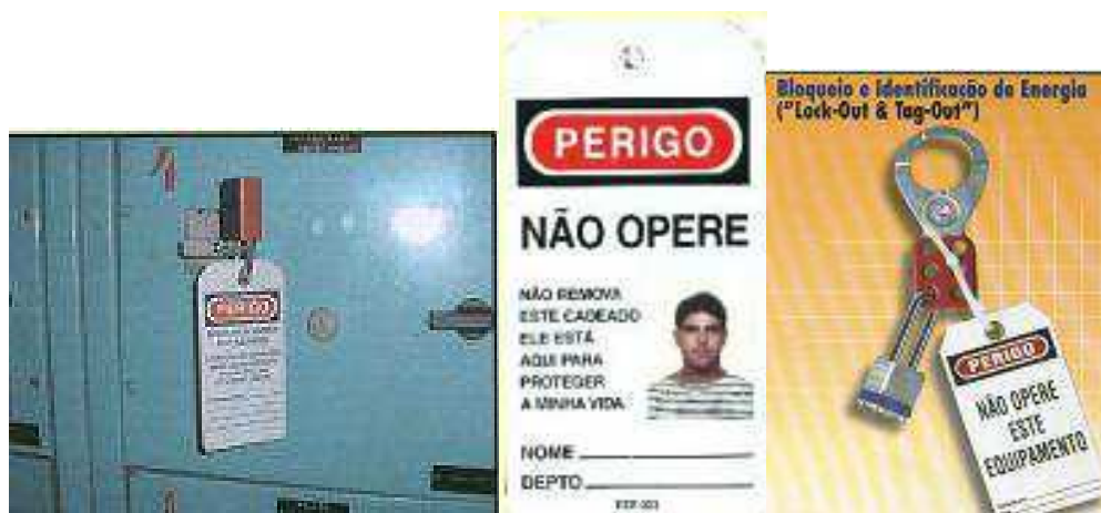
Figura 2: Exemplo de sistema de travamento e sinalização.
