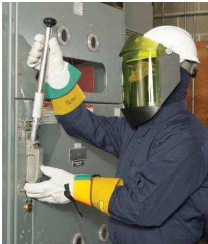
Figura 20: Operário com vestimenta de proteção contra arco elétrico. [16]
