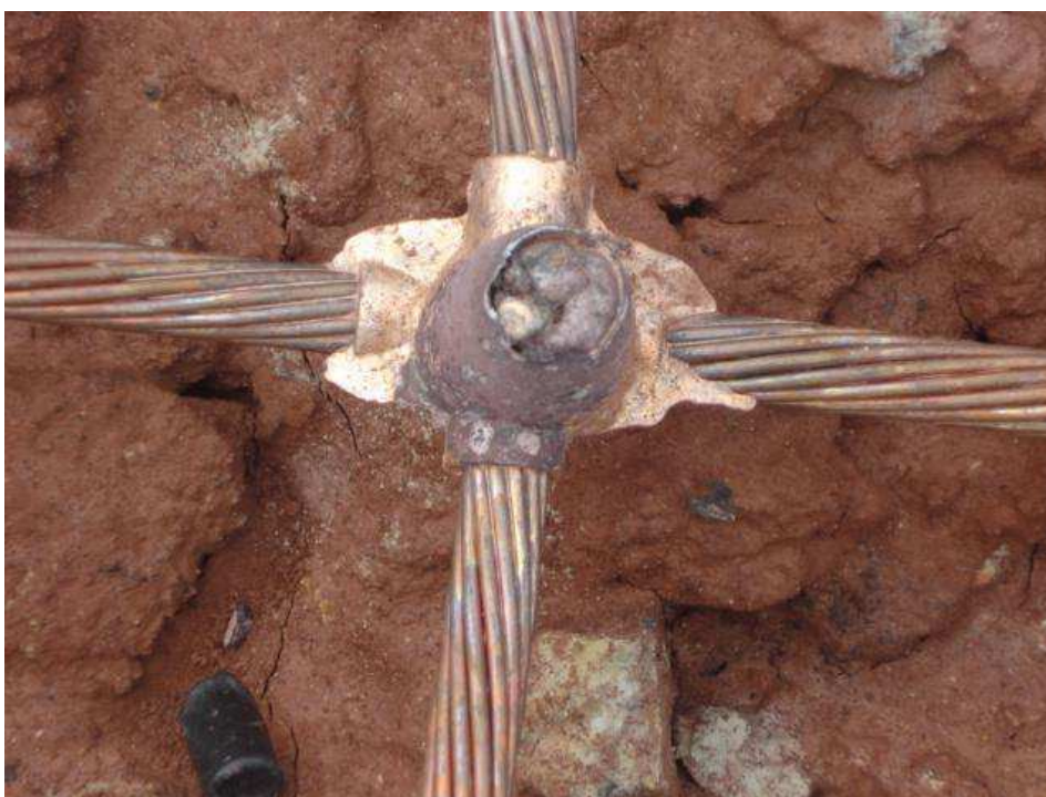
Figura 4: Solda Exotérmica (Molde 'X').
