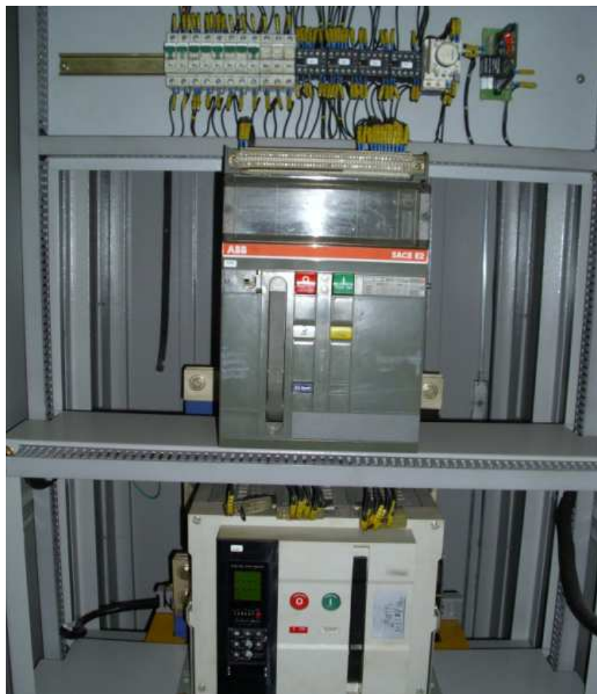
Figura 4 – Sistema de transferência em rampa.
