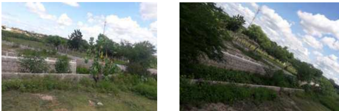
Figura 13 - Galeria de drenagem do Bairro Pereiros.
