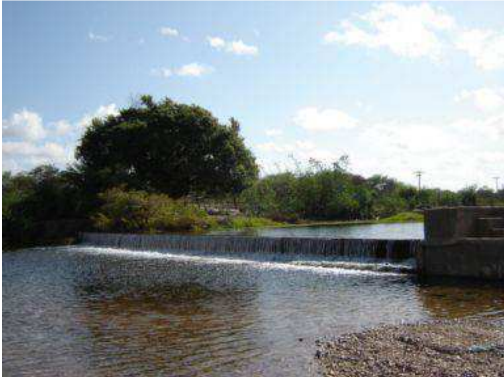
Figura 12 - Barragem do rio Brígida ou Barragem da “rua” no período chuvoso.
