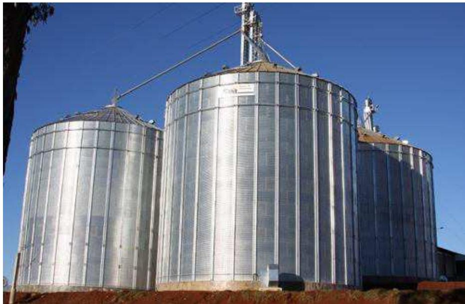
Figura 2 - Silos formados por fundo plano. Fonte: SIM Agroindustrial LTDA (2009)
