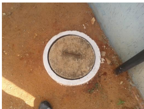
Figura 20 Poço de inspeção do aterramento do SPDA
