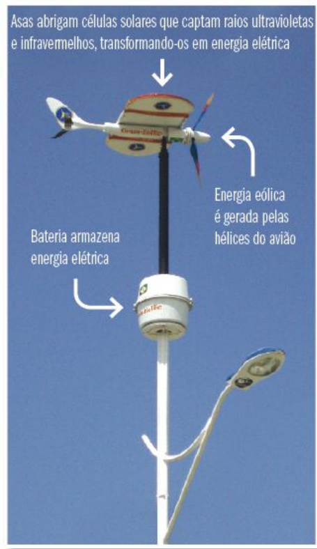
Figura 4.10 - Partes componentes do poste híbrido.
