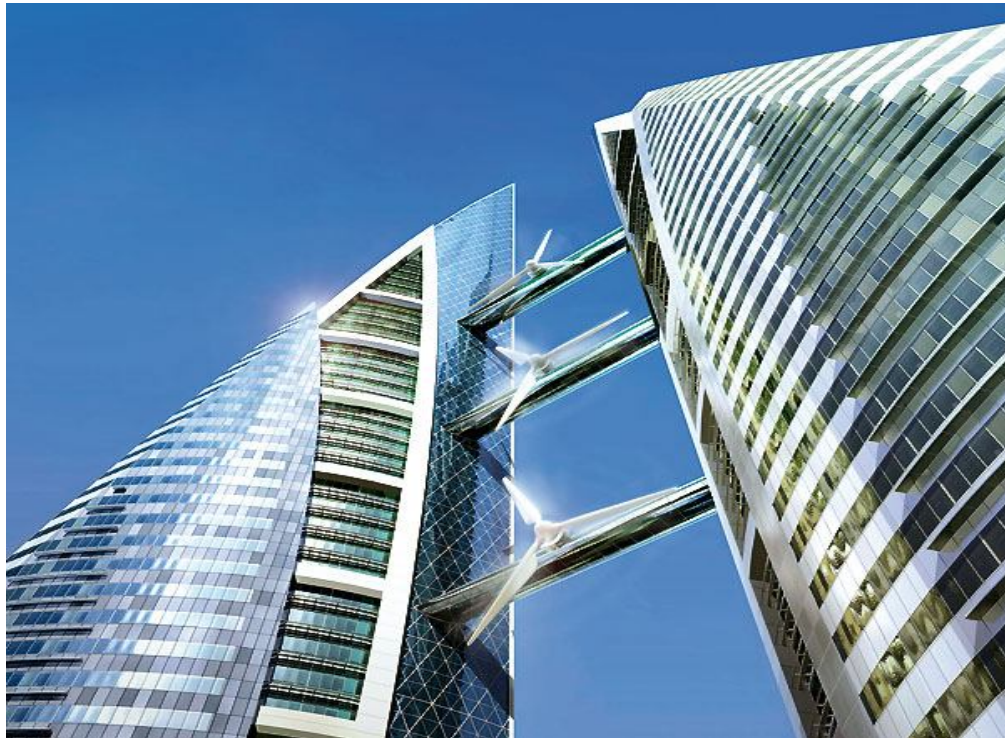
Figura 4.3 – Vista vertical dos 3 aerogeradores do BWTC.
