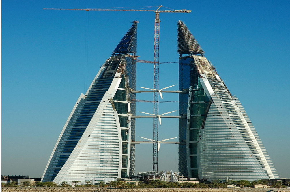
Figura 4.2 – Foto frontal do BWTC em construção.
