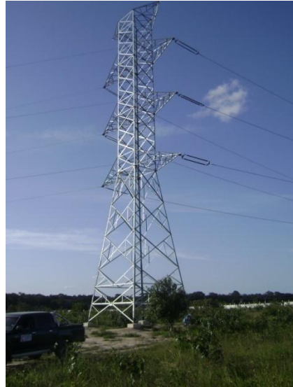
Figura 14. Fotografia da estrutura autoportante em estudo.
