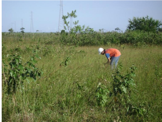
Figura 12. Fotografia das hastes sendo cravadas para medição da resistência de aterramento.
