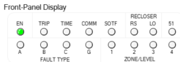
Figura 3.58 – Estado do relé conferido pelo software .
