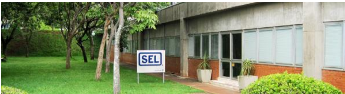
Figura 3.20 - Centro de assistência técnica da SEL no Brasil.
