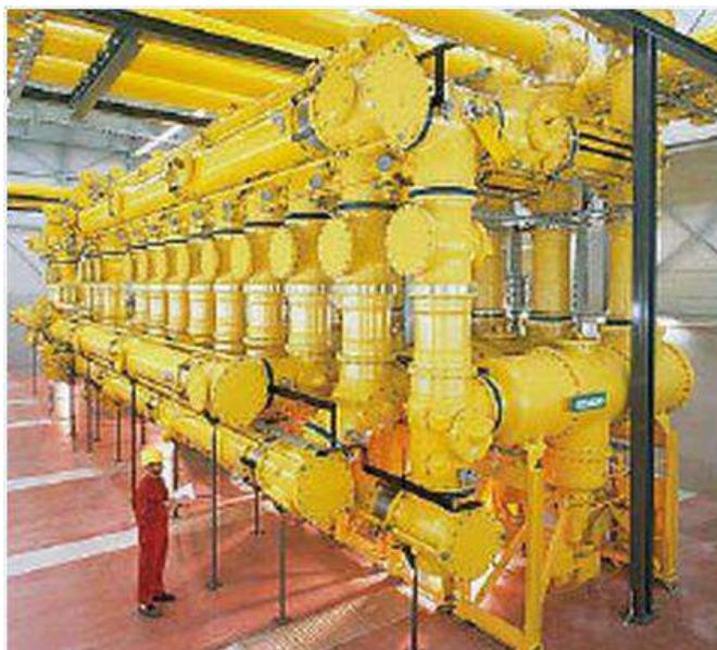
Figura 5 - Subestação blindada isoladas com SF<sub>6</sub> (DUAILIBE, 1999).
