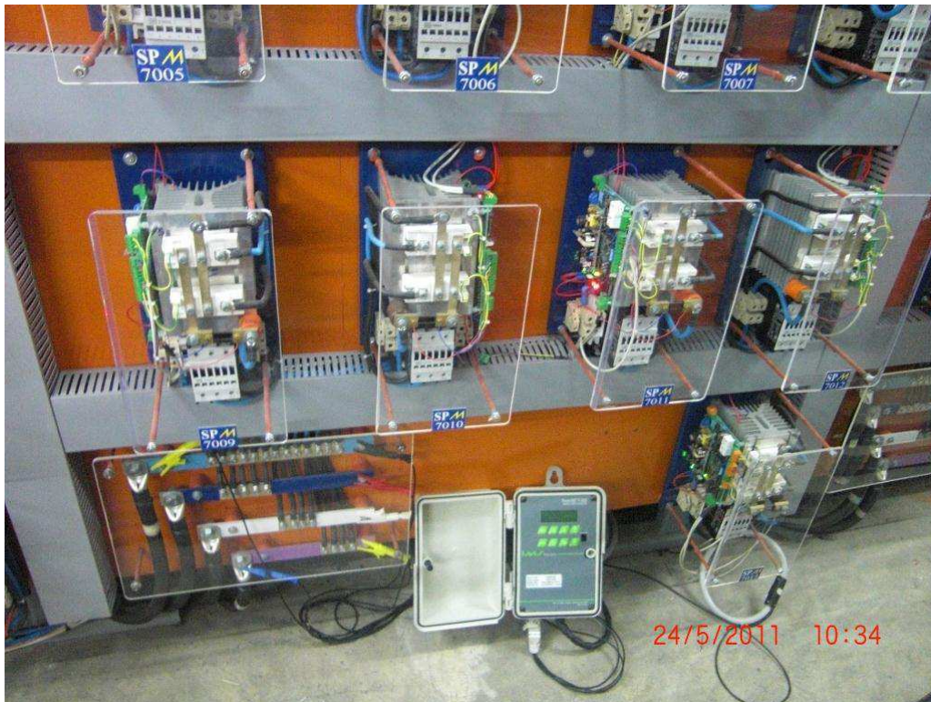
Figura 12-Analisador de grandezas elétricas instalado na seção 05 de formação.
