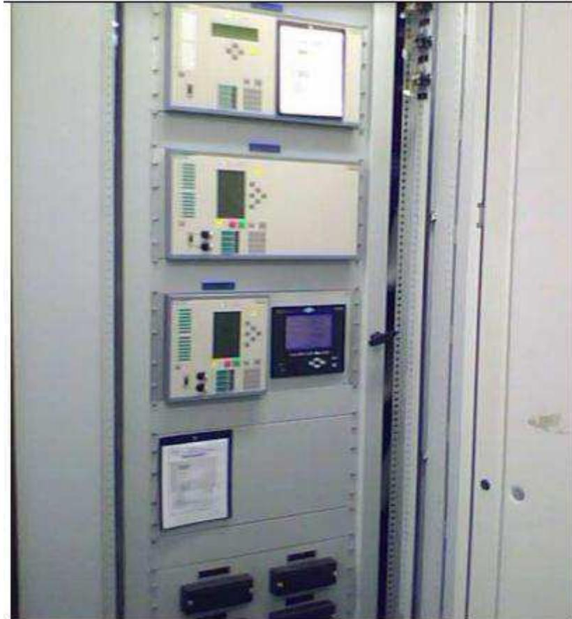
Figura 48: Vista Frontal PNL. Digital de Controle e Proteção Siemens. Responsável pela comunicação entre os reles digitais Siemens.
