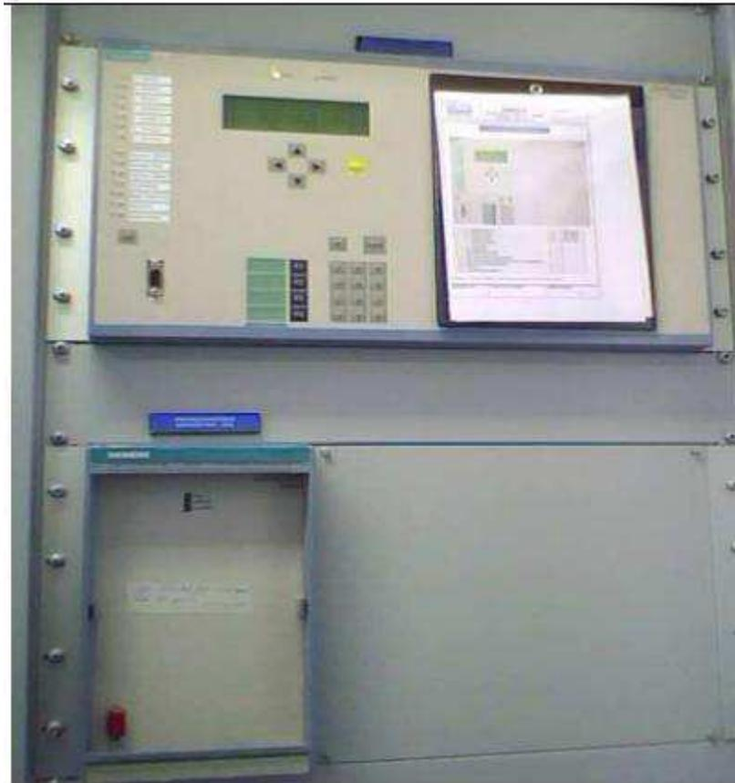
Figura 49: Vista frontal das unidades de controle e proteção Unidades de BAY Siemens (7SS5200, 7S5255).
