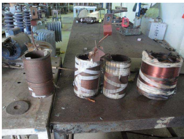
Figura 8 - Bobinas danificadas retiradas do transformador
