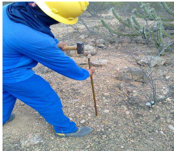
Figura 5-4 - Fotografia mostrando a Cravação da haste de aterramento.
