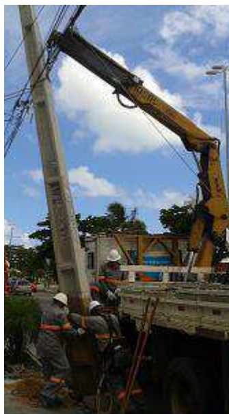
Figura 3. Retirada do poste do solo.
