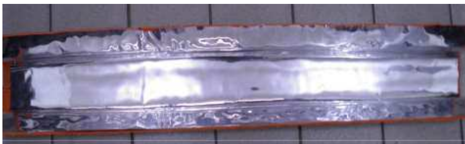
Figura 20 - Peça com a borracha colada nas laterais da cobertura.
