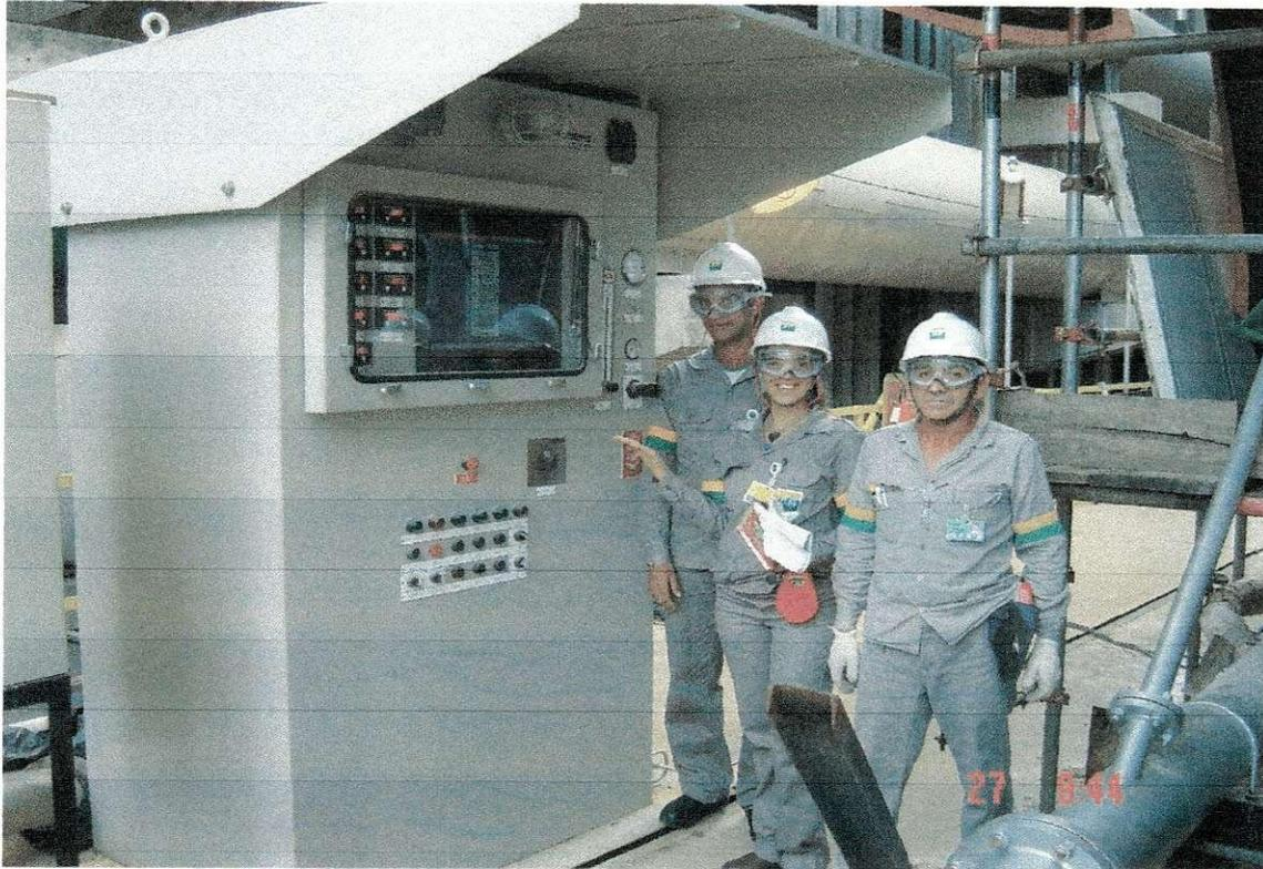
Figura 5 – Painel de controle e Supervisão do Gerador.
