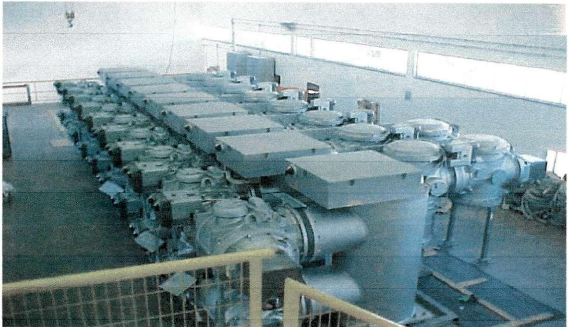
Figura 1 – subestação compactada e isolada a gás  $SF_6$
