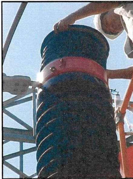
FIGURA 19 – Retirada do pulmão do TPI.
