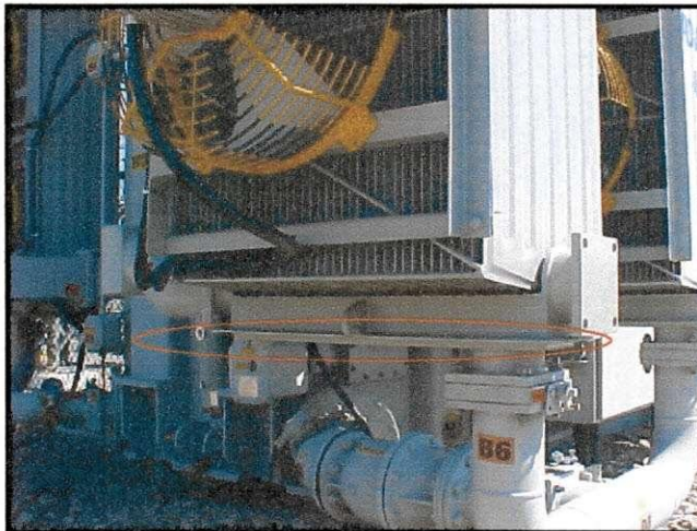
FIGURA 05 – Detalhe do radiador após o processo de soldagem
