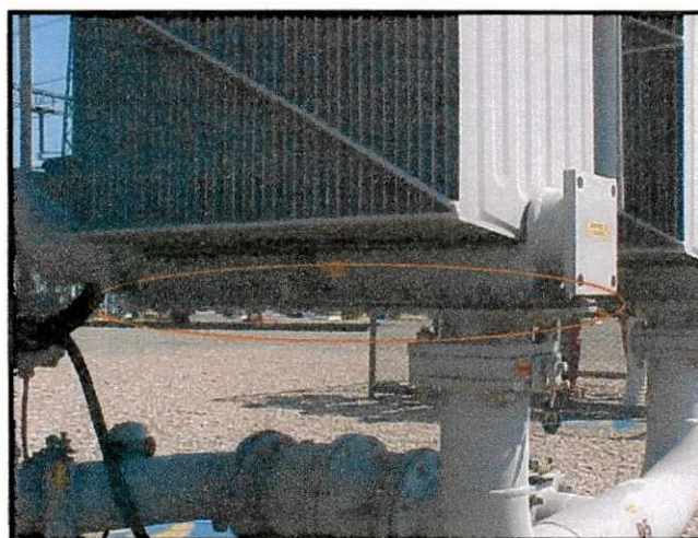
FIGURA 03 – Detalhe do radiador antes do processo de soldagem.
