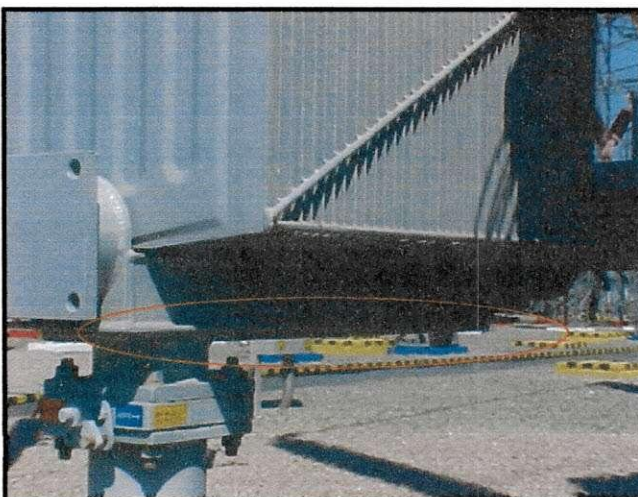
FIGURA 06 – Detalhe do radiador após o processo de soldagem.
