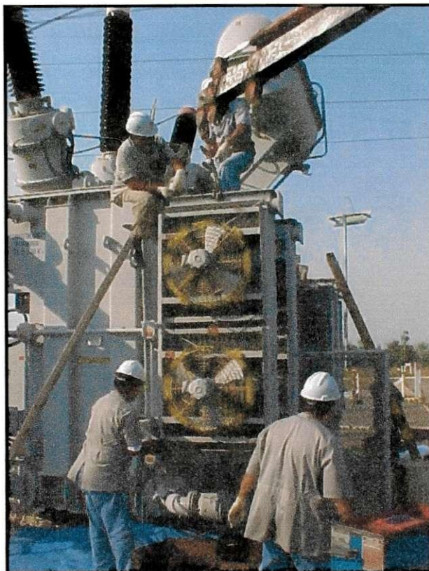
FIGURA 07 – Visualização do transporte do radiador.
