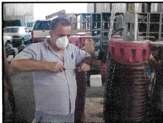
FIGURA 30 – Retirada do gás SF 6 .
