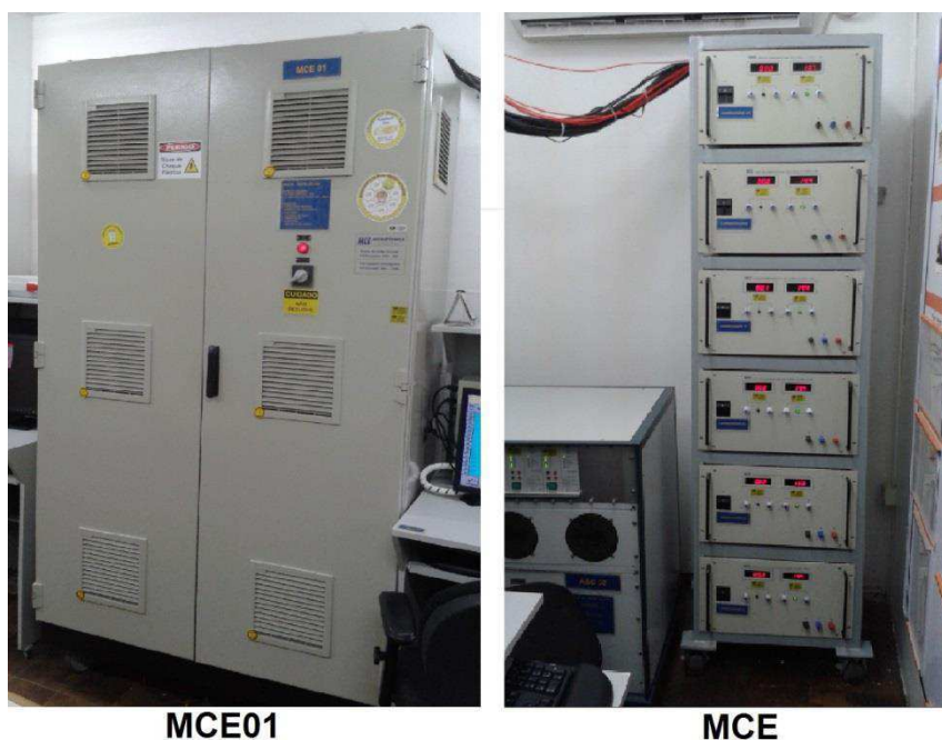
Figura 27 Equipamentos para realização dos teste de Consumo de Água e Aceitação de Carga. Fonte: MOURA(2013)
