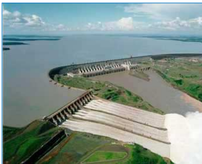
FIGURA 15 – HIDRELÉTRICA DE JIRAU NO RIO MADEIRA FONTE: WILLIAN HEBERT MOTA, 2013
