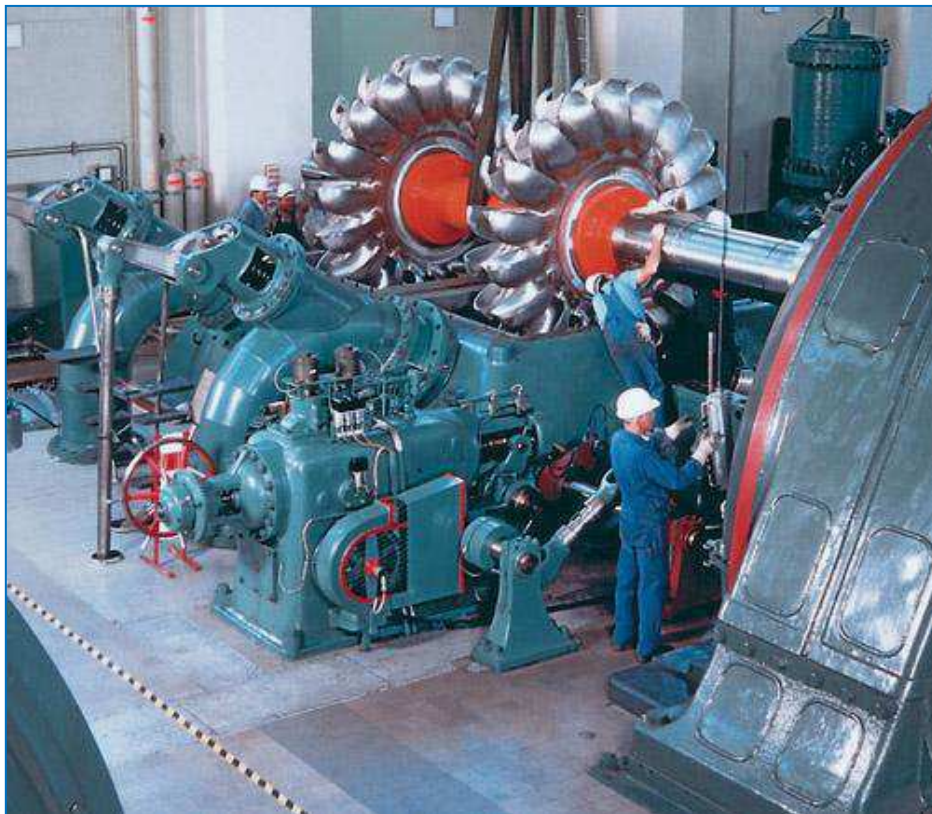
FIGURA 6 - IMAGEM DE UMA TURBINA PELTON EM MANUTENÇÃO FONTE: UNIFEI, 1998.
