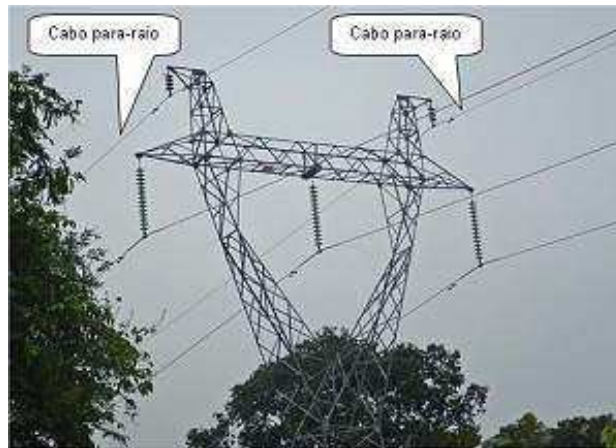
Figura 2.23. Cabos para-raios.
