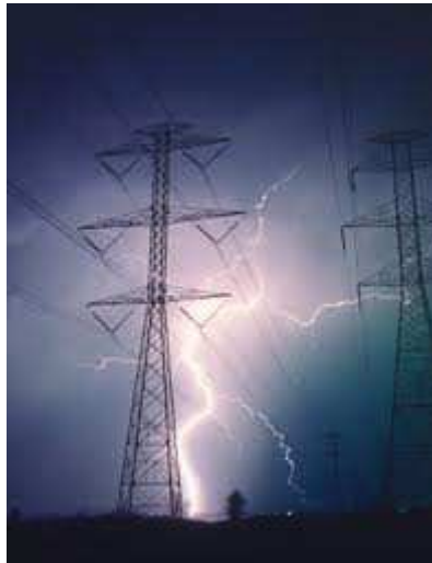
Figura 2.14. Descarga atmosférica sobre linha de transmissão.
