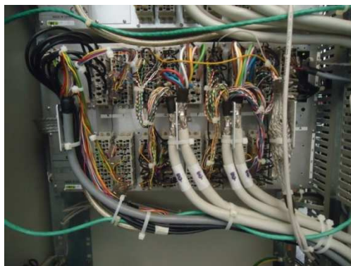
Figura 3.7 Ligações na parte traseira do SIMEAS-R.
