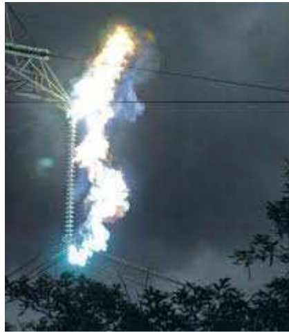
Figura 2.16. Exemplo real de flashover .
