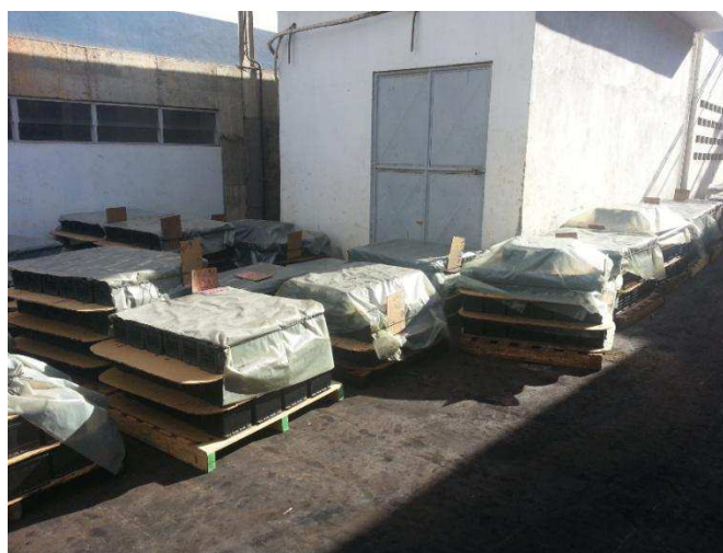
Figura 19 – Obstrução de subestação. Fonte: MARCONNI (2013).
