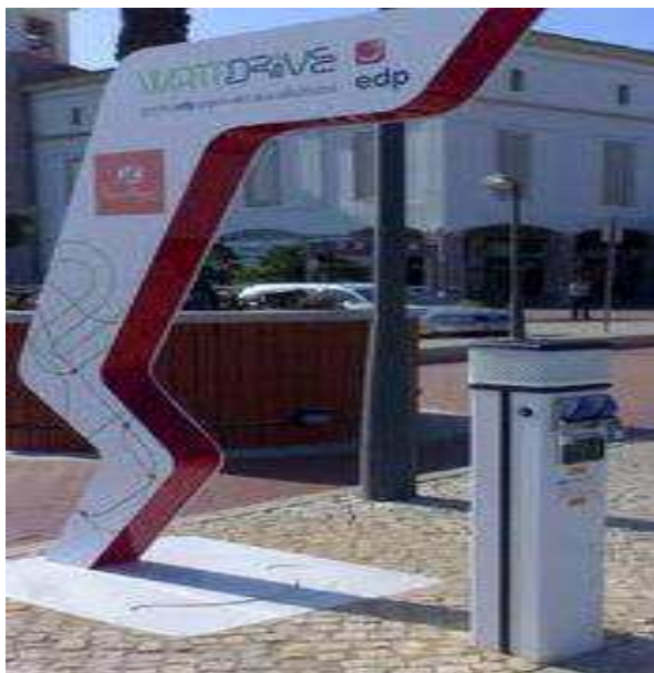
Figura 14 – Posto de abastecimento de carga lenta [12].
