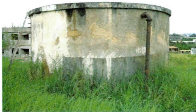
Figura 26 – Reservatório em concreto armado para abastecimento do Campus.
