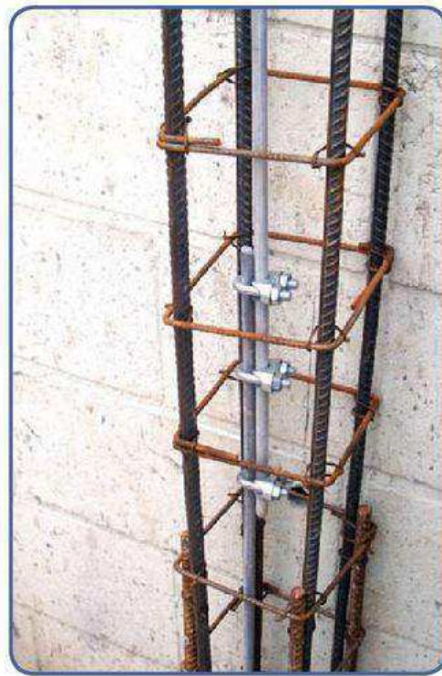
Figura 6. Barra de aço galvanizada a fogo adicional ás ferragens existentes.
