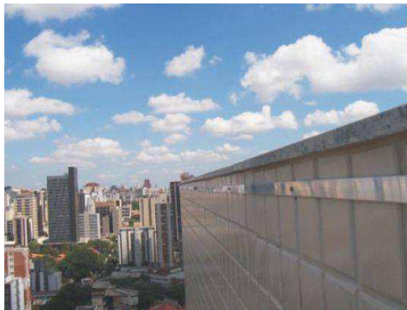
Figura 17. Aplicação da barra chata na captação por fora.
