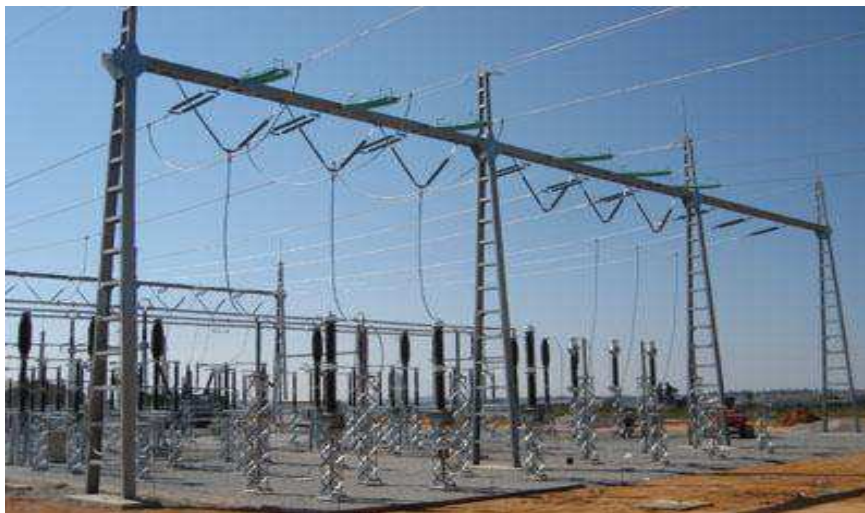
Figura 1. Fotografia de um barramento flexível.
