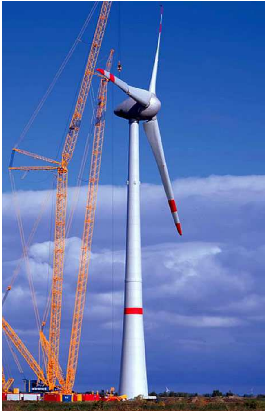
Figura 1-2: Enercon E-126 sendo montada.
