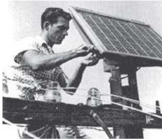
Figura 2. Primeira aplicação de uma célula solar de silício foi como fonte de alimentação de uma rede telefônica local em Americus, na Geórgia, EUA, em 1955.
