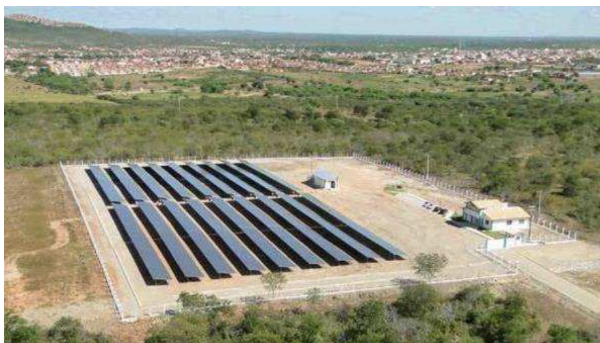
Figura 5.1 Vista geral da Usina Solar de Tauá (1 MW). [32]
