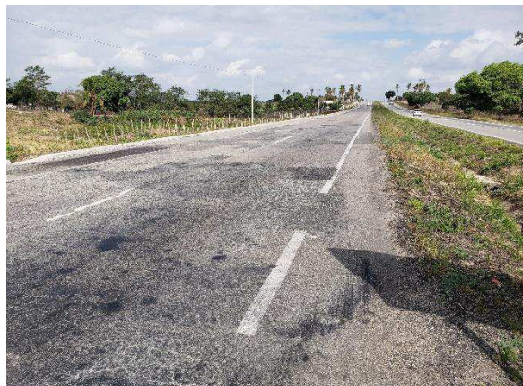
Figura 79 - Trincamentos e deformações presentes no pavimento do SH-02
