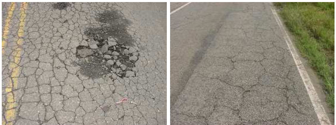
Figura 4 - Trincas interligadas em superfície de pavimento (a) tipo “couro de jacaré” e (b) tipo bloco.
