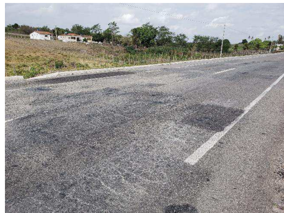
Figura 79 - Trincamentos e deformações presentes no pavimento do SH-02
