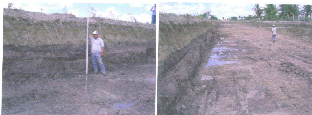
Figura 34 - Rebaixamento do pavimento para implantação do colchão de areia (a) e infiltração de água do lençol freático (b)
