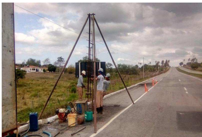
Figura 42 - Sondagens à Percussão (SPT) no trecho
