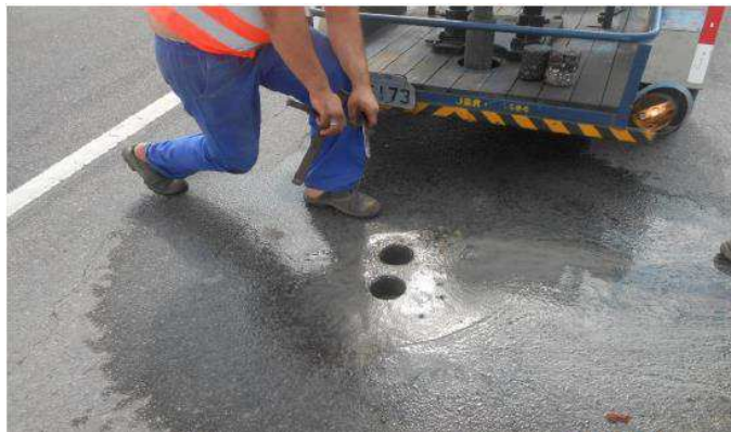
Figura 40 - Extração de corpos de prova por meio de sonda rotativa
