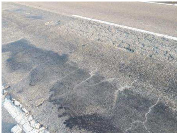
Figura 73 - Defeitos observados na rodovia BR-230/PB – Desgaste
